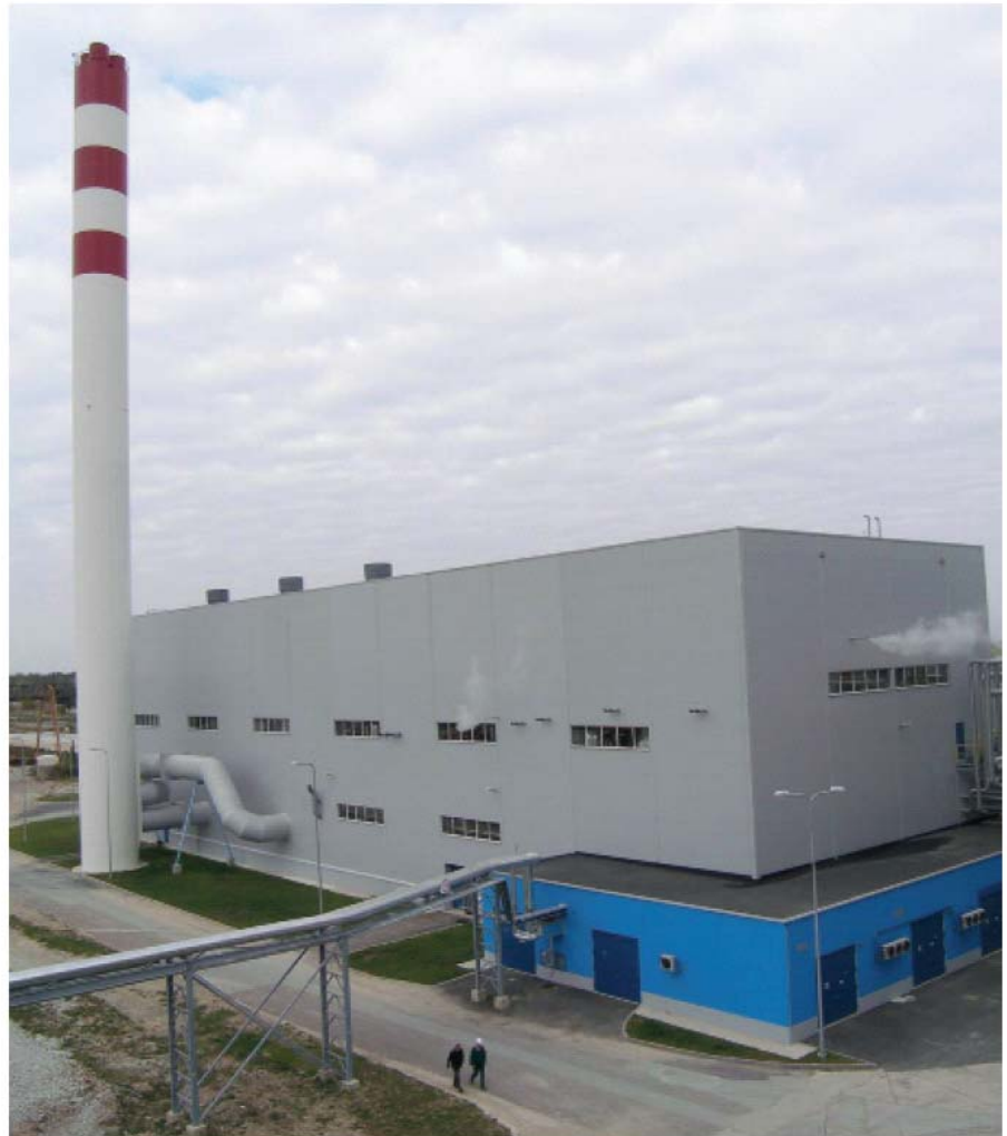
Котельная, г. Нарва.
